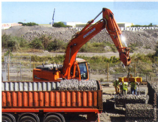
Photo 2 Chargement d'un camion sur l'aire de préfabrication des gabions
