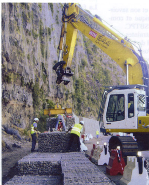
Photo 1 Pose des gabions
