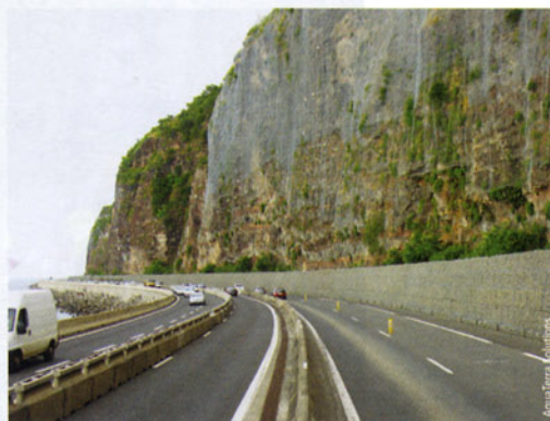
Photo 3 Ouvrage le long de la route du Littoral
