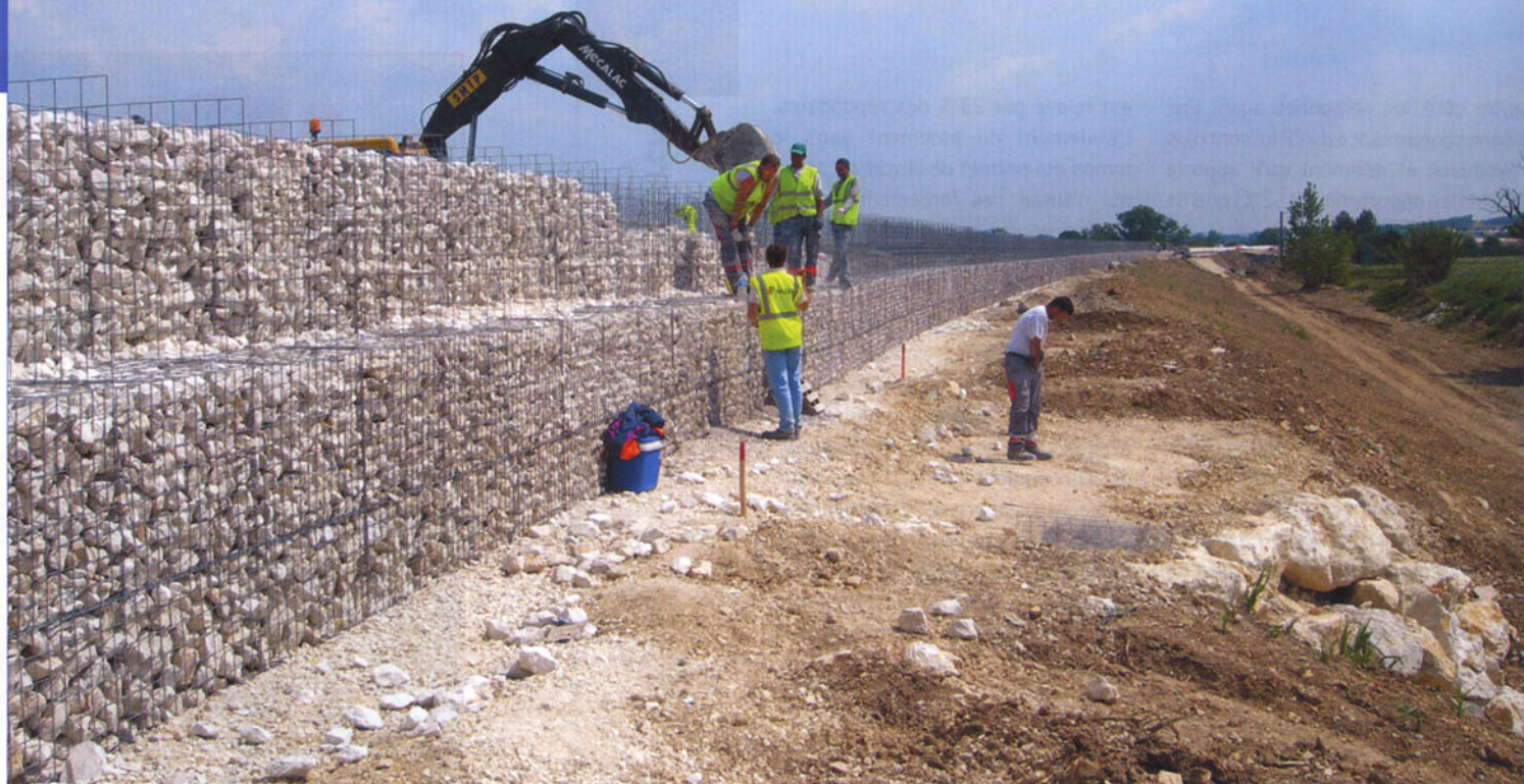
Chantier de mise à 2x2 voies de la RN 106 à Boucoiran (30).
