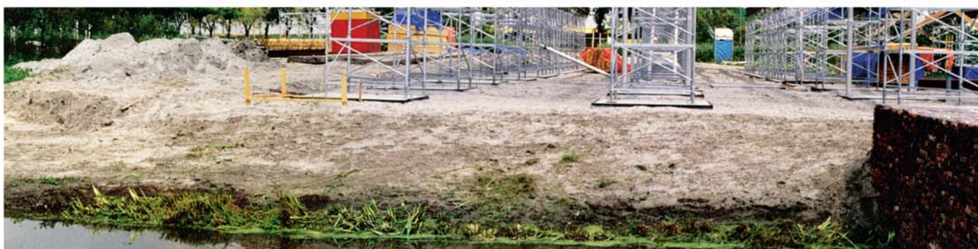
Juillet 2001 : Les géonattes coco viennent d'être installées.
